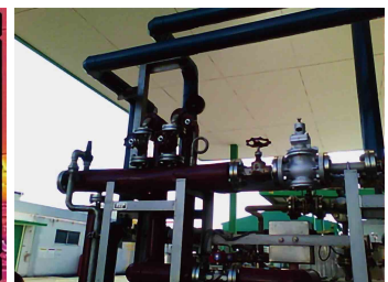
▲ 温水タンクの蒸気バルブからの放熱 (左：赤外線カメラによる熱画像、右：現場写真、文献[1])
