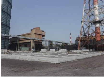
基礎工事(コンクリート4,600m3)
