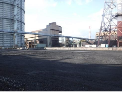
撤去工事後(更地)
