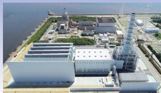
実際に発電を行っている高砂製作所の第二T地点 (資料提供：三菱重工業株式会社)
