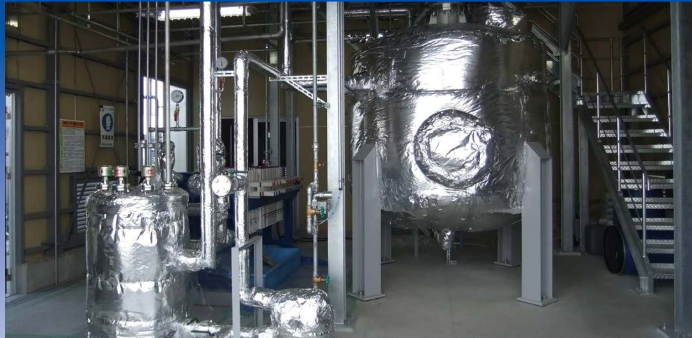
抽出したアルミから水素を製造する水素製造装置（資料提供：アルハイテック株式会社）
