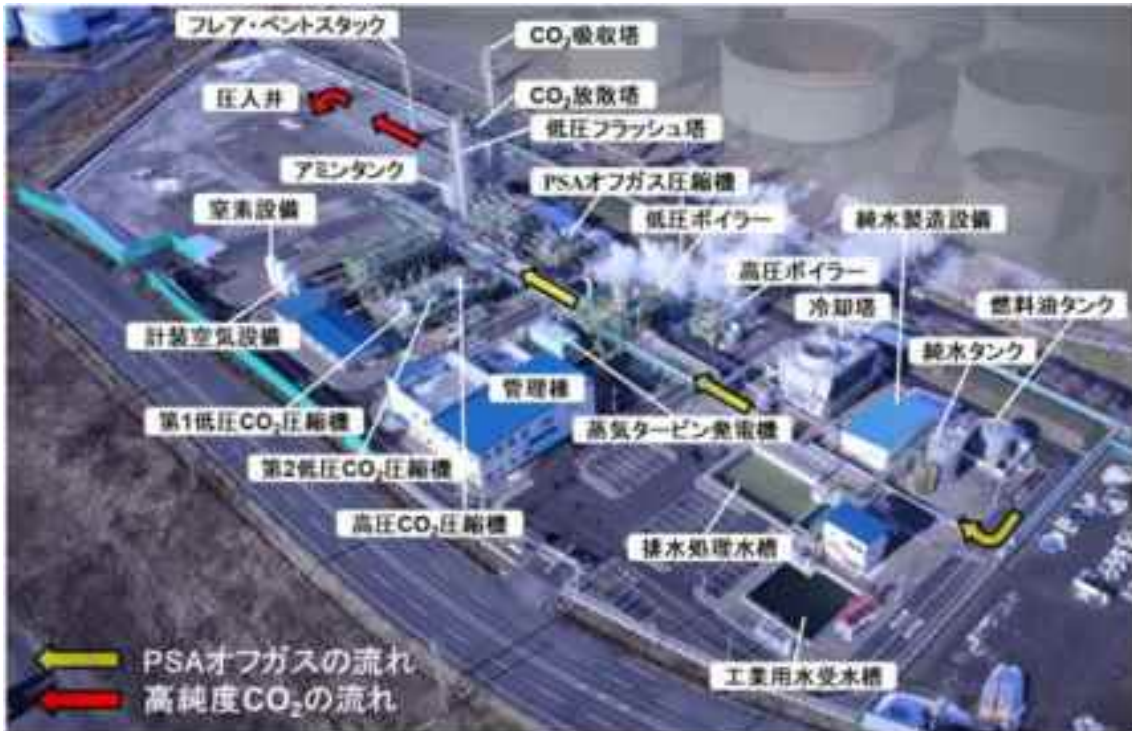
図 1.3-1 分離・回収/圧入設備の俯瞰図
