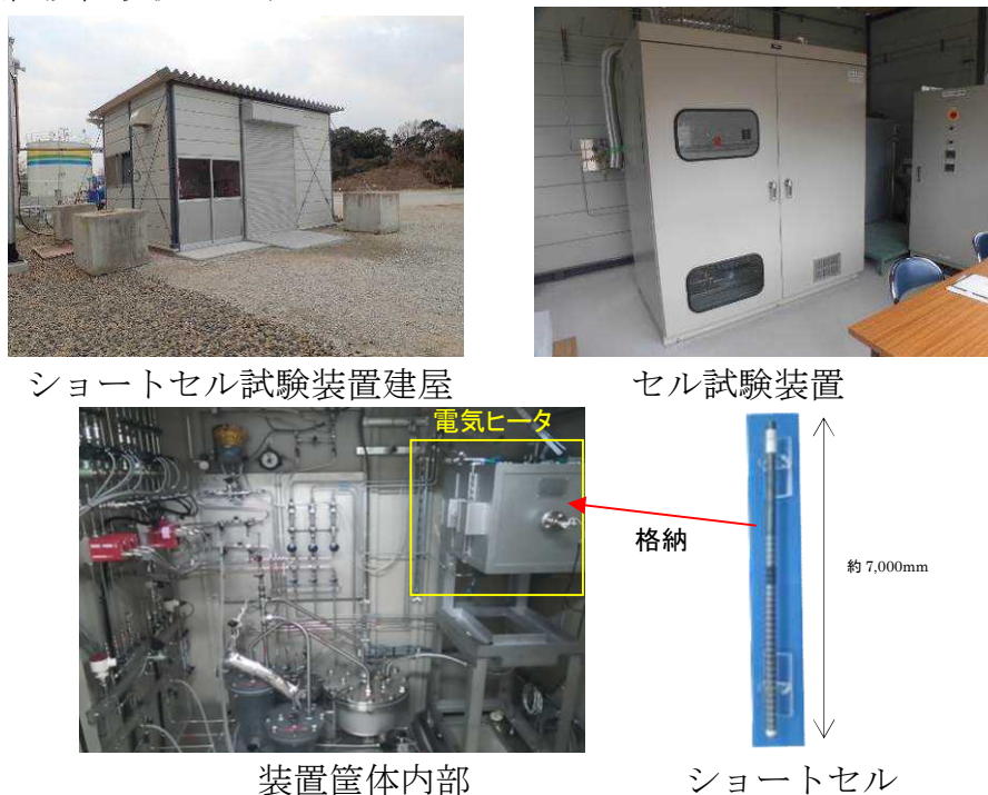
図3-46 試験装置設置状況
