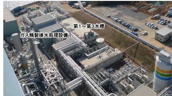
図 3-13 排水処理設備
