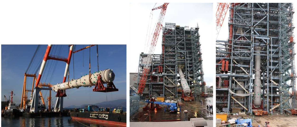
図 3-18 ガス化炉搬入・据付状況
