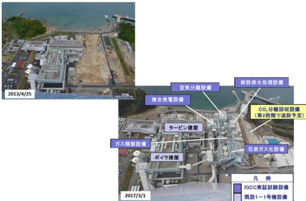
図3-19 設備全体写真（煙突より）
