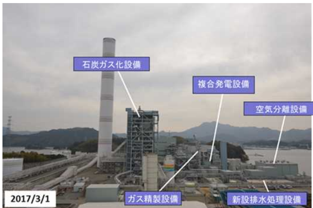
図3-20 設備全体写真（西側より）
