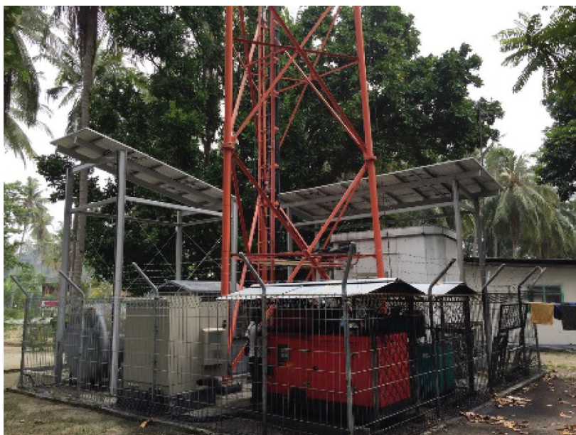
基地局に導入されたトライブリッドシステム / Sistem TRIBRID yang diintroduksi ke BTS
