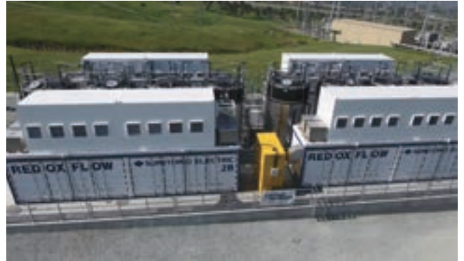
大型蓄電池を用いた実配電網でのマイクログリッド運用(カリフォルニア州)
