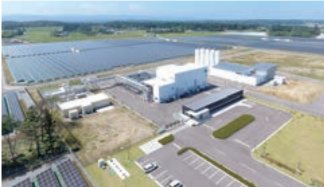
福島水素エネルギー研究フィールド(FH2R)全景
