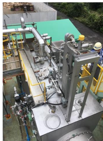
ボイラ外観 (手前: 燃焼ガス入り側)
