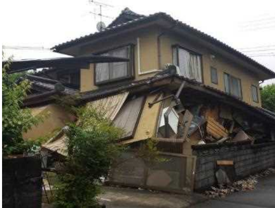
図Ⅲ-2-④-(4)-15 直下率の低さやPVによる屋根の重さが原因で、一階部分が倒壊したと思われるケース
