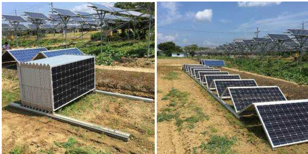
図Ⅲ-2-①-(3)-9 開発した折りたたみ架台
