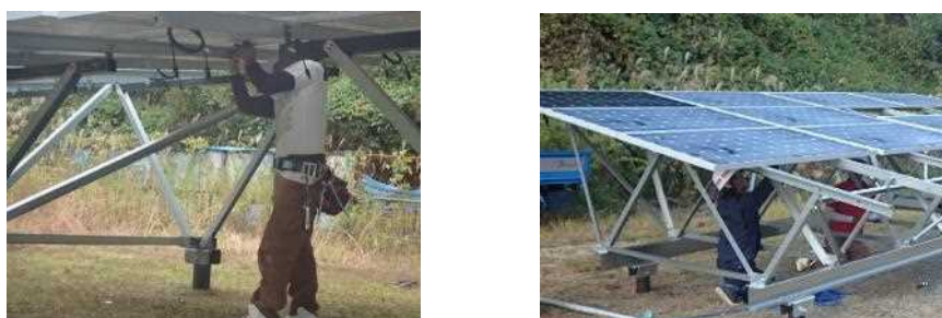
図Ⅲ-2-①-(5)-8 架台の組立状況
