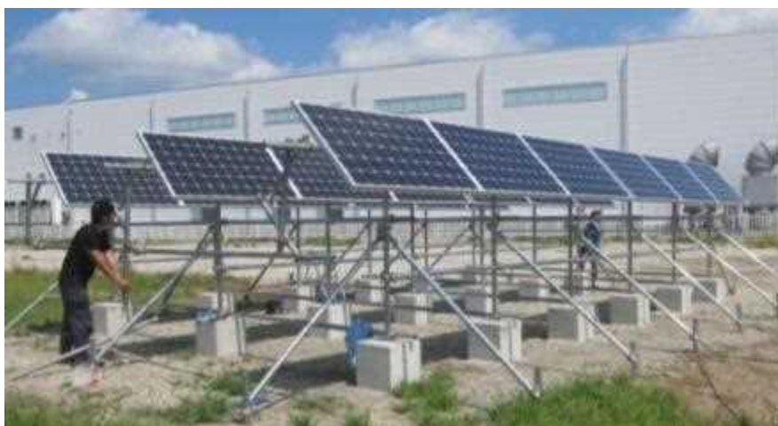
図Ⅲ-2-①-(2)-11 低価格手動可変架台の実証モデル
