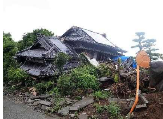
図Ⅲ-2-④-(4)-15 直下率の低さやPVによる屋根の重さが原因で、一階部分が倒壊したと思われるケース
