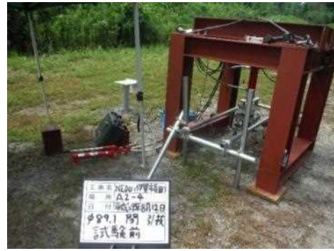
図Ⅲ-2-④-(3)-5 引抜載荷試験状況
