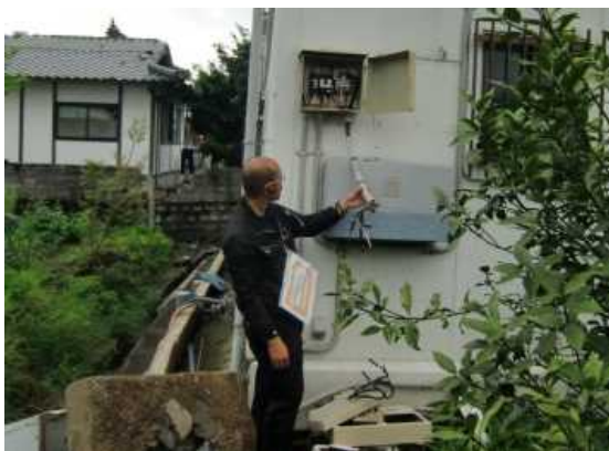
(下) 分電盤のブレーカは切ってあったが、パネルから PCS までの電流は流れていた
