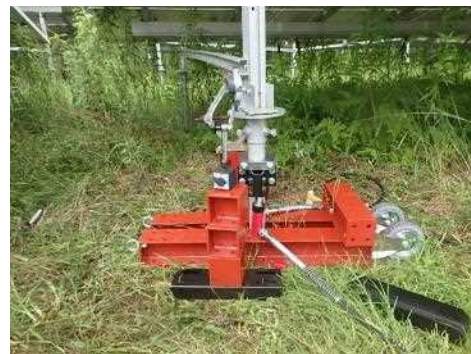
図Ⅲ-2-④-(3)-7 引抜載荷試験状況(既設杭)
