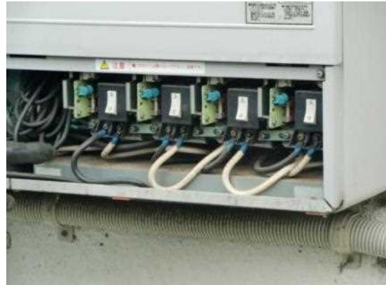
(下) 分電盤のブレーカは切ってあったが、パネルから PCS までの電流は流れていた
