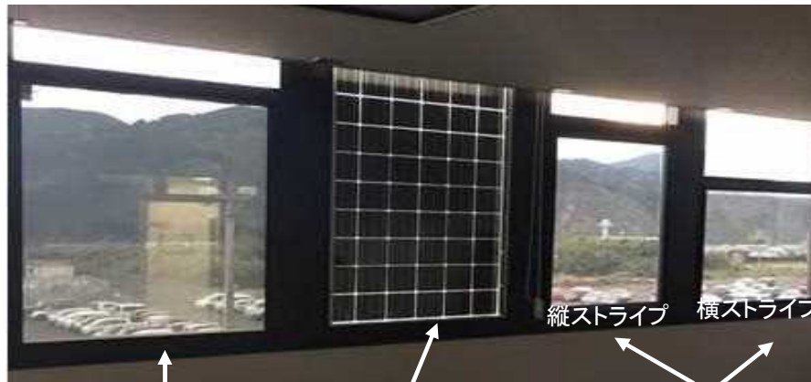
シースルー太陽電池 開口率20% 両面受光太陽電池 開口率5% 両面受光太陽電池 開口率50%
