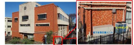
図1 岐阜市内の公民館建屋に導入したオープンループ型地中熱利用空調システム
