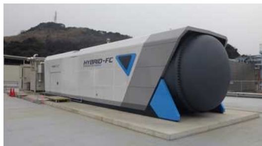
図 3-2-3-9 燃料電池モジュール試験設備
