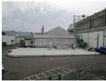
主要機器据付前 敷地全景
