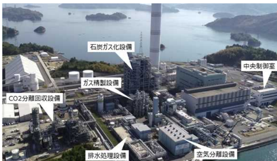
図 2-1-1 大崎クールジェン(株)全景 (出展：大崎クールジェン(株)より提供)
