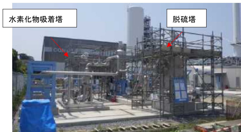
図 3-2-3-29 燃料電池用ガス精製設備（追設工事中）
