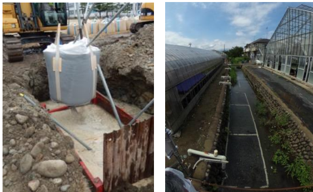
図表 4 流水熱利用型熱交換器の設置イメージ※2 (左) 浅層地下水 (右) 農業用水
