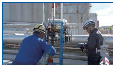
配管へのロボット設置
