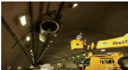
実フィールドでのセンサ端末設置作業
