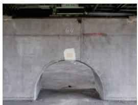
接着シートによる貼り付け
