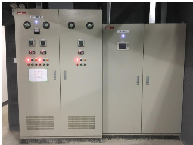
自動制御盤 (アズビル社)
