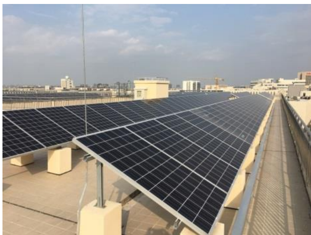
太陽光発電パネル 85kw (京セラ) (270W×315枚)
