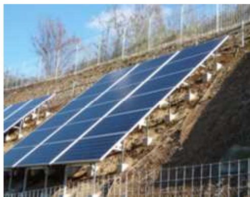
太陽電池モジュール設置後
