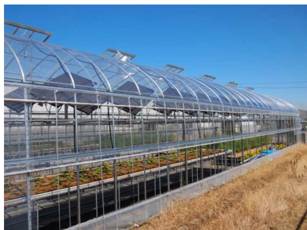
図Ⅲ-2-①-2-5 農業ハウスに設置した追尾型太陽光発電システム
