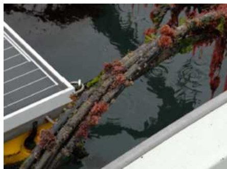
図Ⅲ-2-①-9-4 実フィールド試験後引き上げた架台写真
