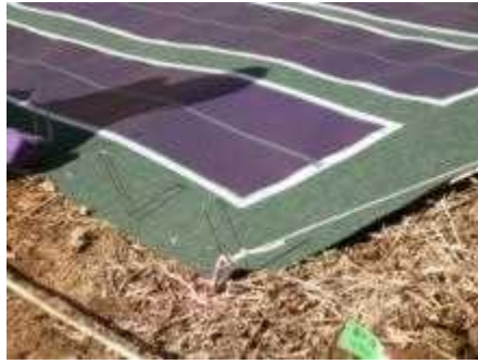
図Ⅲ-2-①-6-9 シート型太陽電池（アモルファス）の施工状況
