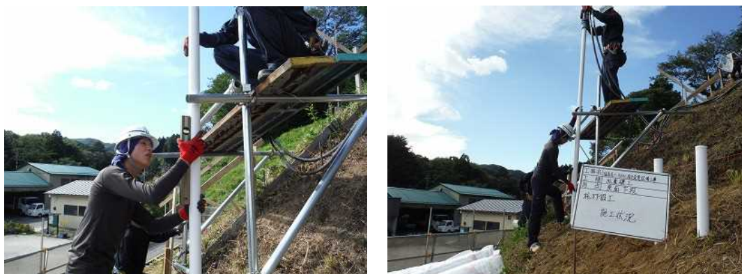
図Ⅲ-2-①-7-14 重機を使用しない施工工法
