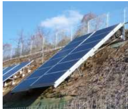
太陽電池モジュール設置後
