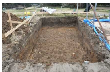
<地盤75cm掘削>
