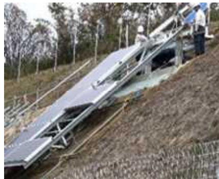
図Ⅲ-2-①-6-4 試作1号機による太陽電池モジュールの設置状況
