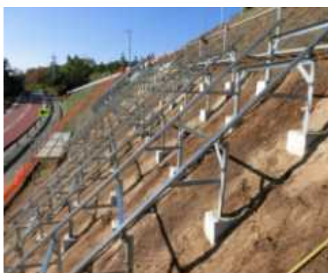
太陽電池モジュール設置前
