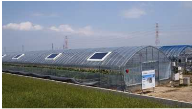
図Ⅲ-2-①-4-10 社内実証ハウス外観
