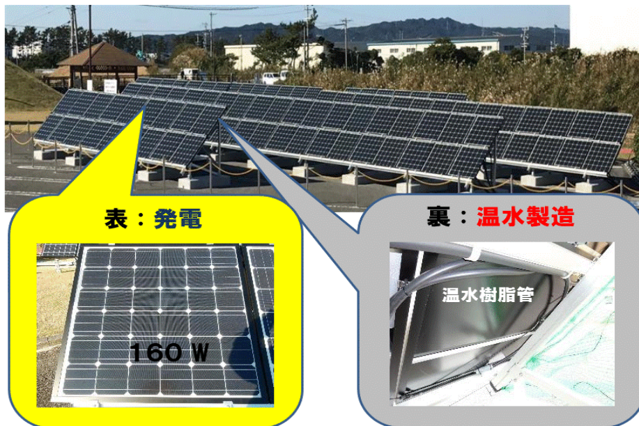
図Ⅲ-2-③-14-16 実証プラントの外観と「温水」ラインのパネル連結方法
