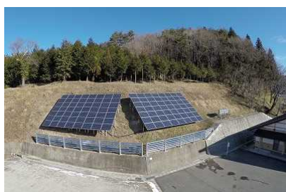
図Ⅲ-2-①-7-20 川内村 実証サイト
