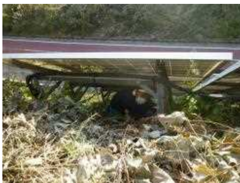
除草及び点検作業の状況
