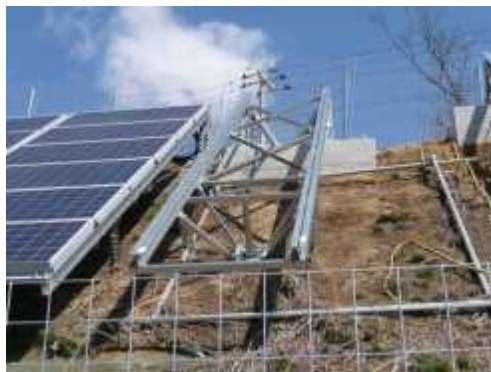
太陽電池モジュール設置前
