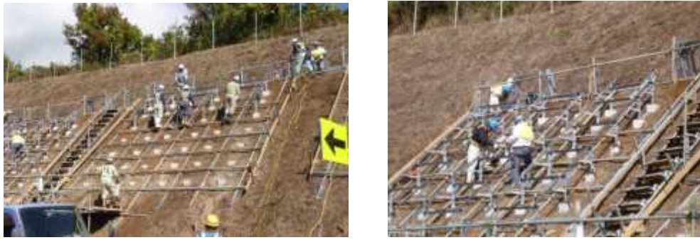
図Ⅲ-2-①-6-7 埋込基礎架台の施工状況
