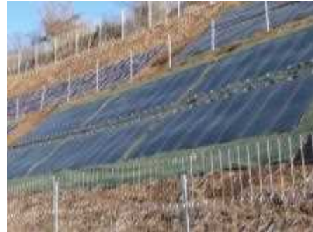
太陽電池モジュール設置後
