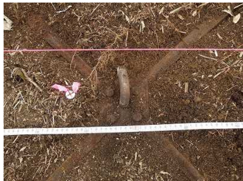
図Ⅲ-2-①-7-15 法面保護工
