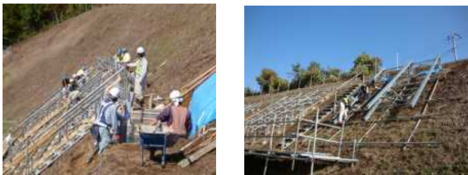
図Ⅲ-2-①-6-8 アジャスト架台の施工状況
