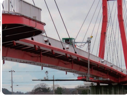
県管理橋梁での実験 2018/1/5
