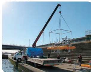
運搬フレームにより4つユニットだけで容易に設置・撤収が可能 (作業者の水上作業なし)
