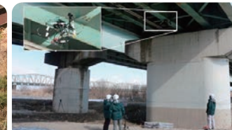
鋼桁への適用例 橋梁着脱・アーム式カメラモジュール使用
