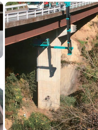
点検車上からの運用 従来点検手法との組み合わせの一例
