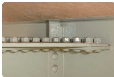
ロボットカメラ画像(上部ウェブギャップ板)
