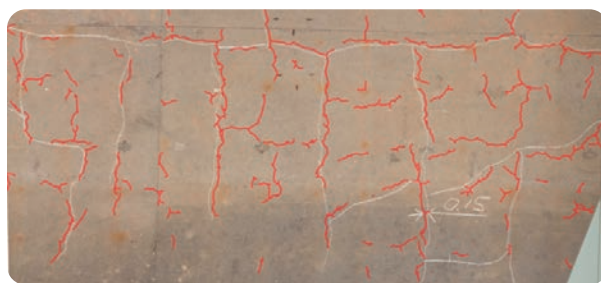
ロボットで撮影された高精細画像に対するひびわれ自動検出の結果
