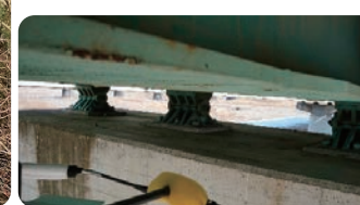
支承付近の画像
