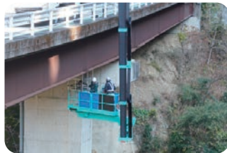
桁下に展開し安全索を設置
