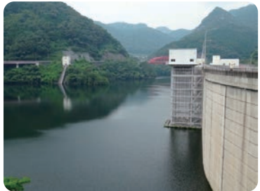
重力式コンクリートダム
