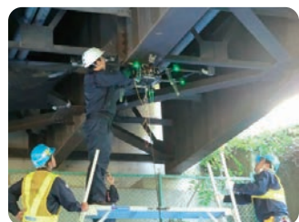
主桁への取り付け
