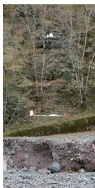
電磁探査の計測状況
