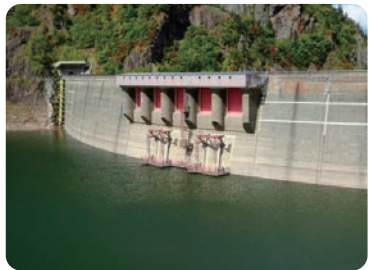
アーチ式コンクリートダム
