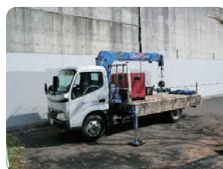
電源(200V発電機、400V昇圧器)
