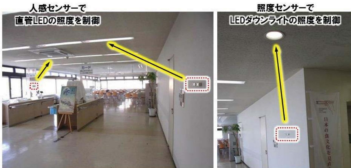
図 1.2.2.4-2 無線センサーと照明の配置.
