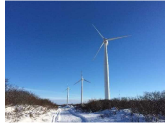
稼働中の風力発電システム (平成28年1月)
