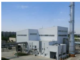
<タシケント熱電併給所>
