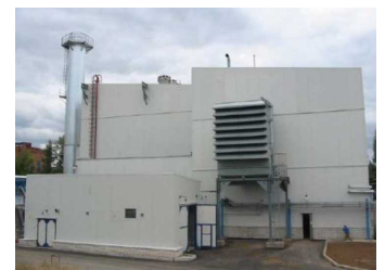
<H-25熱電併給設備>
