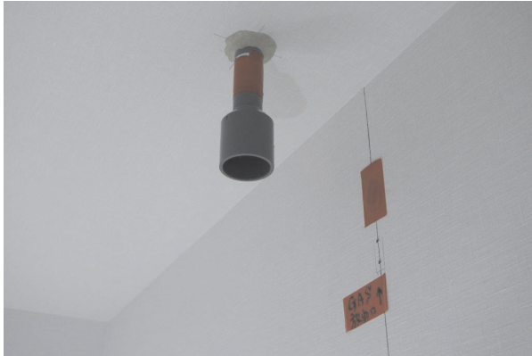
図 2.2.4.2.1-3. \phi 60\text{mm} 漏斗型放出口の様子
