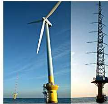
洋上風車(左)、洋上風況観測タワー
