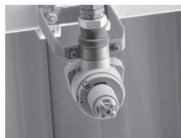
(e) 耐圧防爆型漏洩検知器
