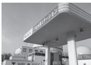
(a) 供給設備建屋
