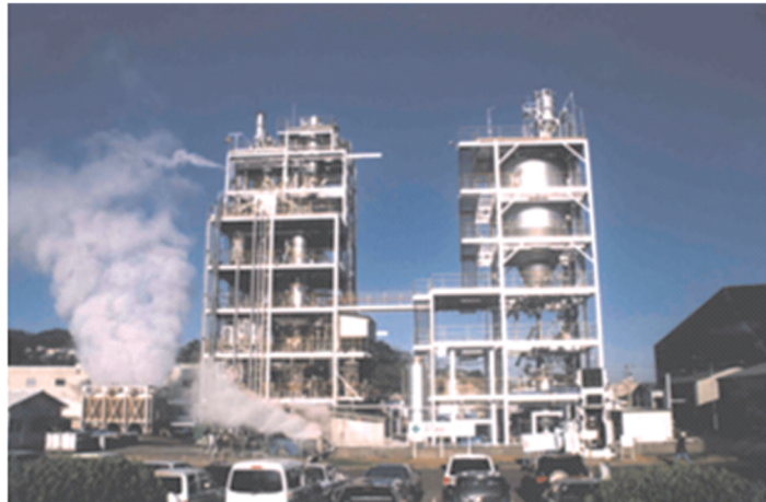
図 3-1.2 50TPD ガス化炉試験設備
