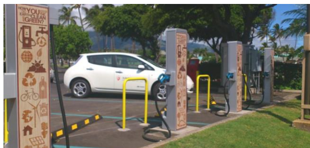
図15 急速充電ステーションの例
