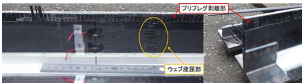
図Ⅲ-2.7.7-5 試験後の構造破壊状況
