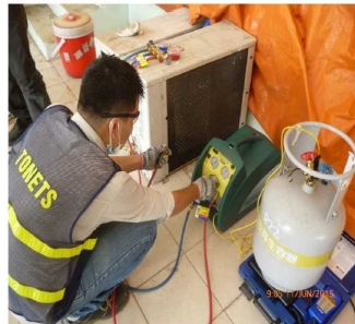
フロン回収装置(写真中央の緑・黄色の装置)を使用してエアコン内のフロンを回収
