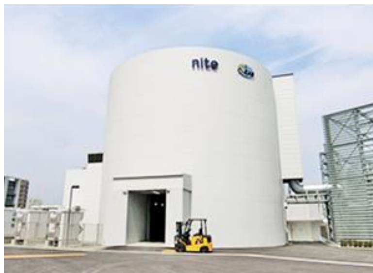
図 I -34 NLAB 多目的大型試験棟
