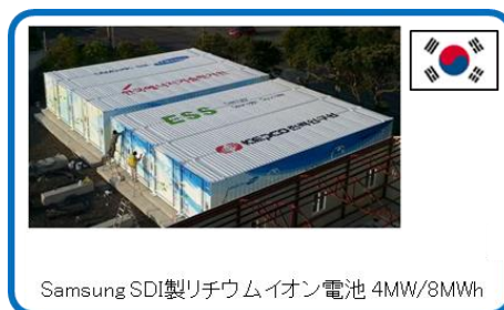
図I-25 済州島スマートグリッド実証で導入されたリチウムイオン電池システム
