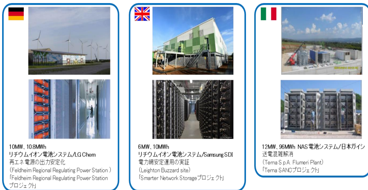
図 I -21 欧州に導入されている大規模蓄電システムの例
