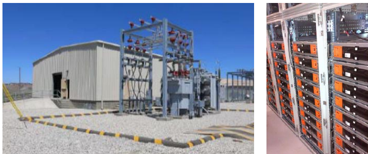
8MW/32MWh リチウムイオン電池システム/LG化学 (カリフォルニア州; Tehachapi Wind Energy Storage Project)
