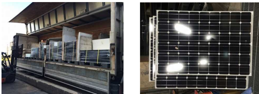
図Ⅲ-2-②-(3)-2（左：太陽電池パネル搬入状況、右：搬入された太陽電池）
