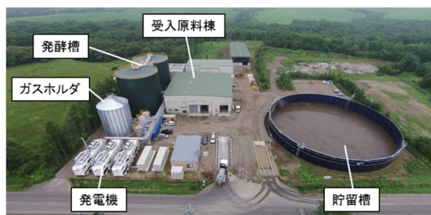
別海バイオガスプラント
