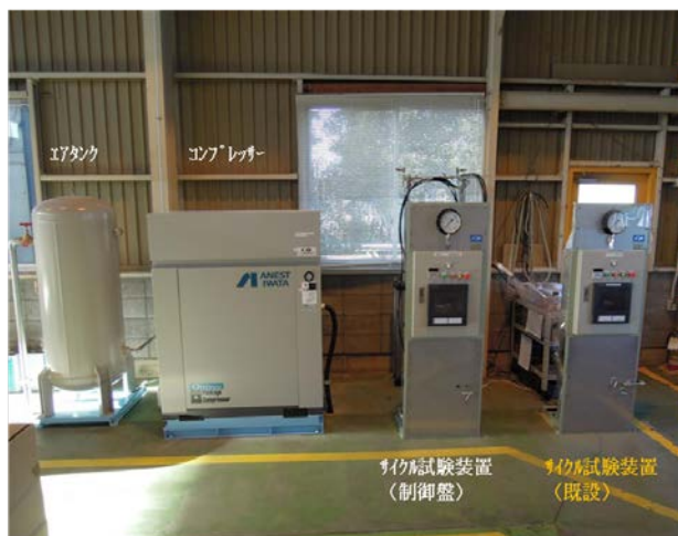
Fig. 10 圧力サイクル試験装置外観
