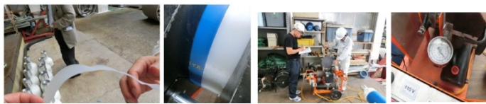
写真左より、①切削カットした時出てきた切削片、②切削後切削端面の合わせ部写真、③熱板温度測定の写真、④熱板装着時のプレス圧力計の設定圧力確認
