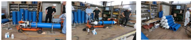
写真左より、①溶着する鏡部とPE管とをセットした所、②両端に鏡部、中央のPE管に溶着している所。及び出来上がった樹脂ライナーの写真
