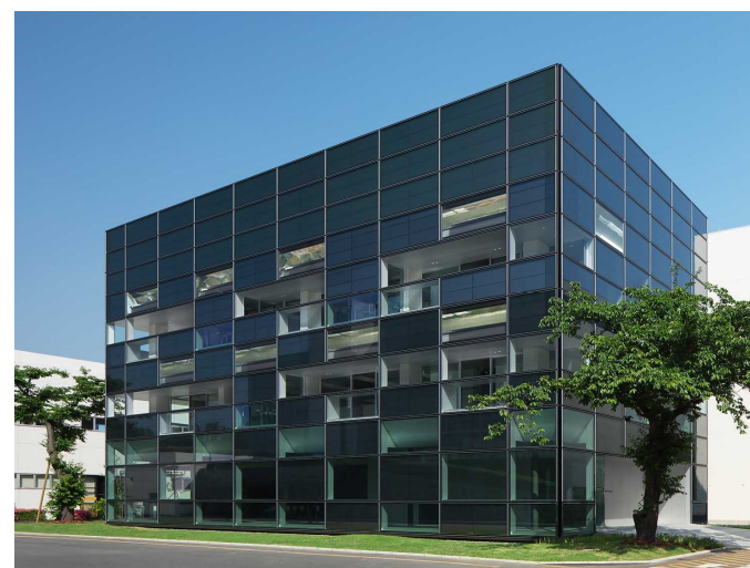
OPVの特長である高いデザイン性を活かしたOPV壁面用ユニット（三菱化学） 大成建設での実証試験中
