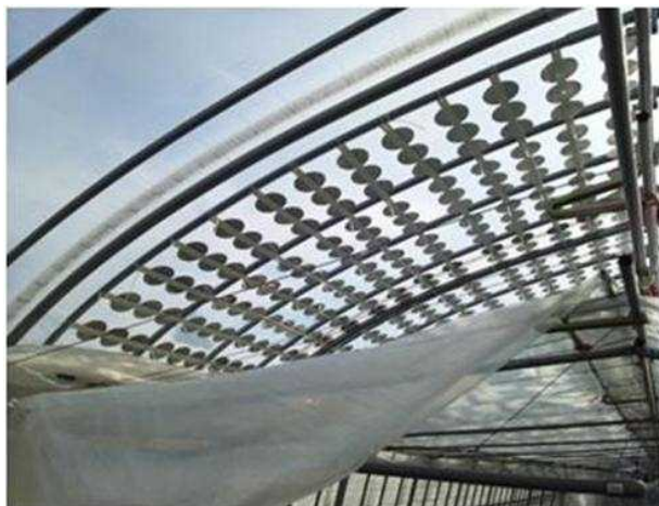
ビニルハウスの天井部分を利用した ソーラーシェアリング(太陽誘電、ビフレステック)
