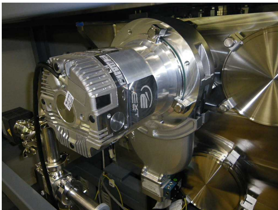
図Ⅲ-2. 18. 11 主排気ターボ分子ポンプ
