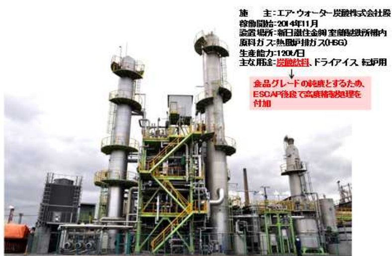
図IV-3 CO 2 分離回収技術商用一号機(ESCAP)の概略
