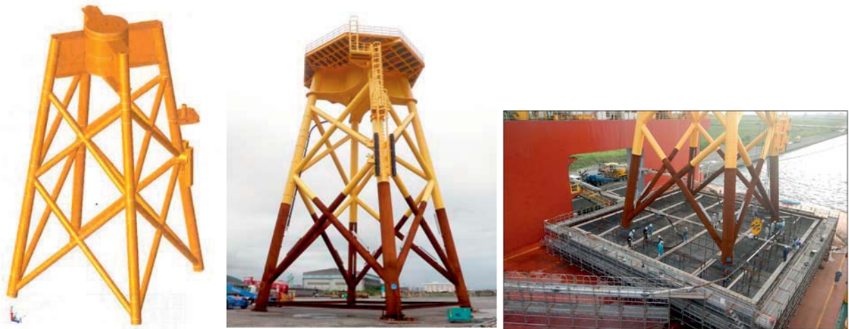
図 3.4.5-6 北九州市沖サイトにおけるハイブリッド重力式支持構造物 左図は底板コンクリートの打設状況(電源開発資料)
