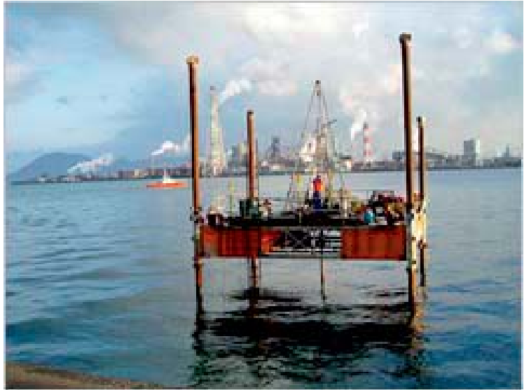
図 3.4.4-2 ボーリング調査の例(大和探査技術 HP)
