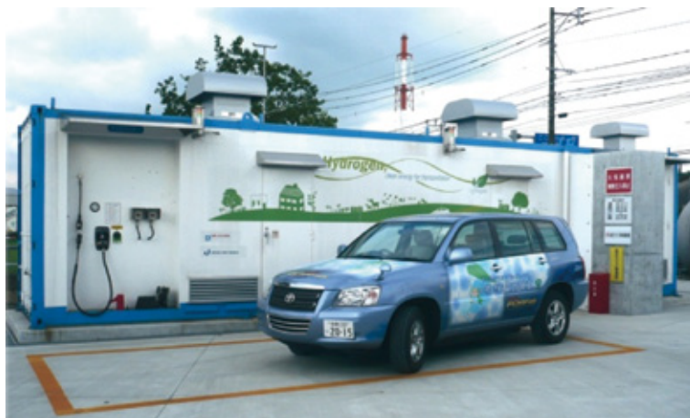
図 2-24 鳥栖水素ステーション (日本エア・リキード)
