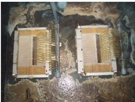
図Ⅲ. 2. 5-10 浄化槽の膜分離槽に設置された膜ユニットの写真及び運転条件
