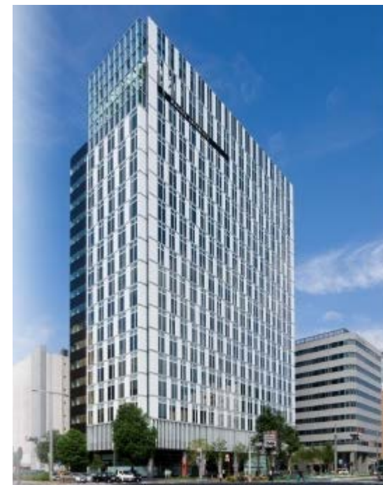
実証試験ビル外観 階数: 地上19階、地下3階 延床面積: 約37,000㎡
