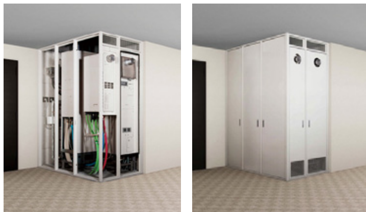
商品外観（パイプシャフト内設置時） パイプシャフトの扉を閉じた状態 パイプシャフトの扉を開いた状態
