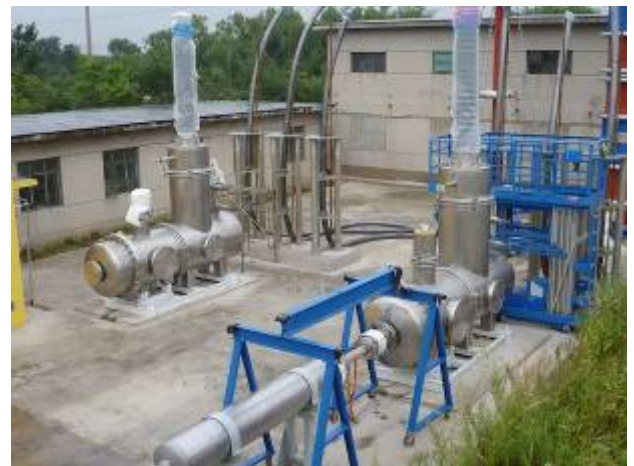
図 2.2.4-9 終端容器の設置（左）、ケーブルと終端容器の接続（右）
