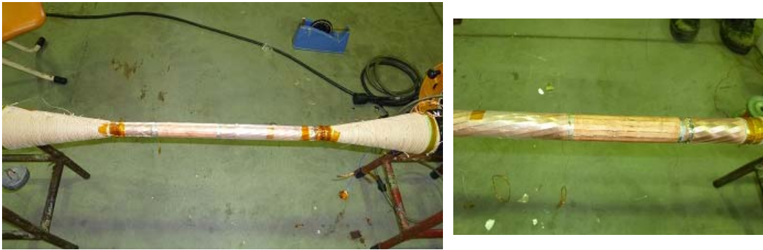
図2.2.3-78 超電導ケーブル接続の組立（接続抵抗は3.6 nΩ）
