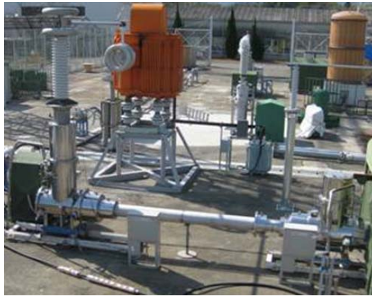
図 2.2.1-92 中間接続部の課電試験風景
