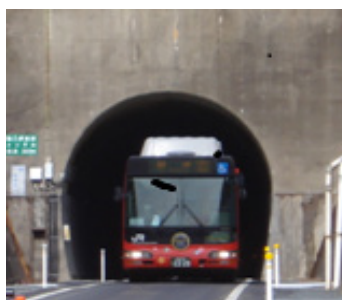
トンネル部道路
