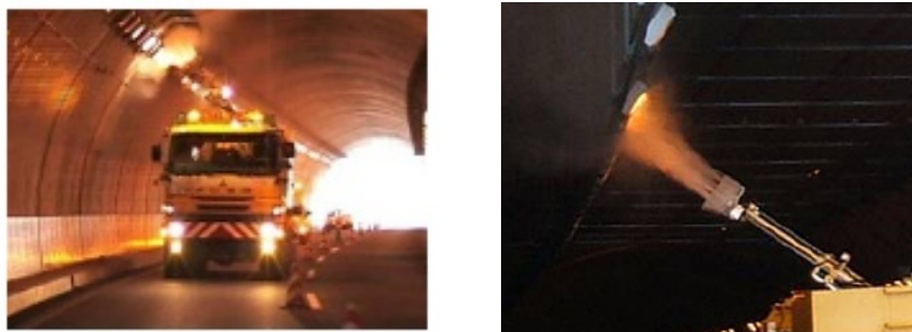
図IV.1-5 トネル照明灯具清掃車による清掃風景とキャビテーションヘッド部
