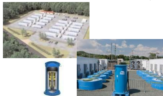
20MWプラント@米国NY州Stephentown (Beacon Power社 フライホイール)
