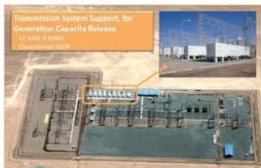
12MW/4MWhプラント@チリ・ロスアンデス (AES Energy Storage社/A123社 リチウムイオン電池)
