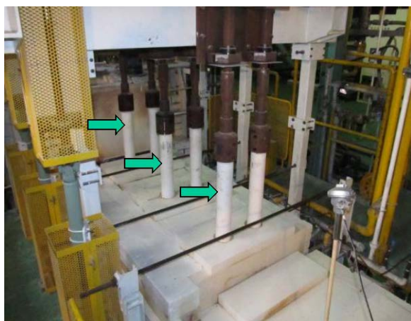
図III-2-③-1-6 試験炉均質槽
