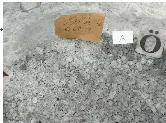
解体後の炉内状況
