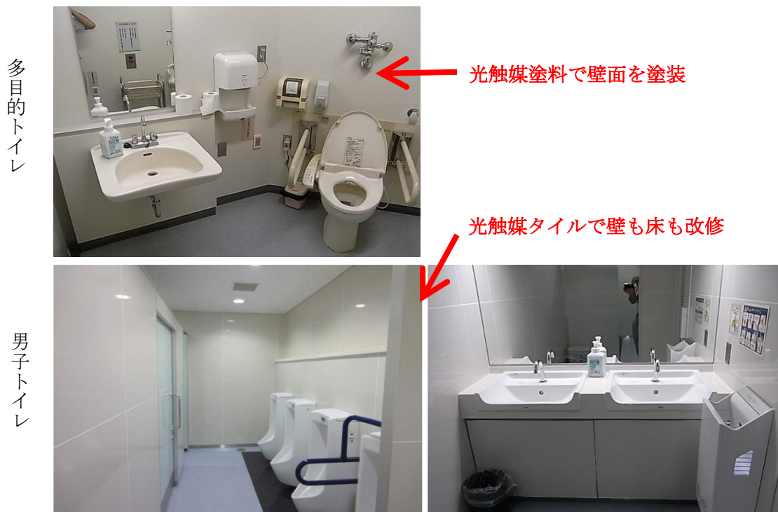
図Ⅲ-2-⑤-31 横浜市大病院での実証試験現場の様子
