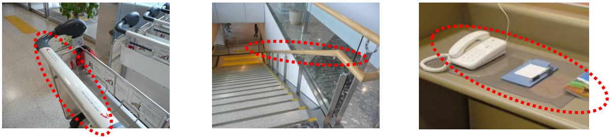
図Ⅲ-2-③-21 新千歳空港における可視光型光触媒フィルムの施工事例
