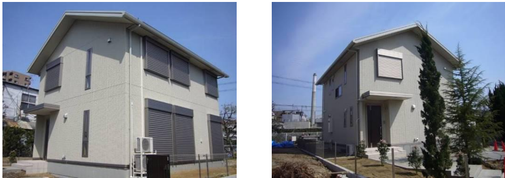
図3 実証住宅の外観
