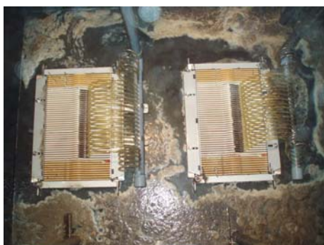
図Ⅲ. 2. 5-9 浄化槽の膜分離槽に設置された膜ユニットの写真及び運転条件
