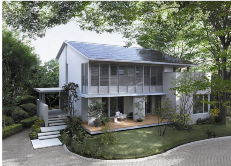
図 c-1-7 建物Bの外観(ミサワホーム展示場)
