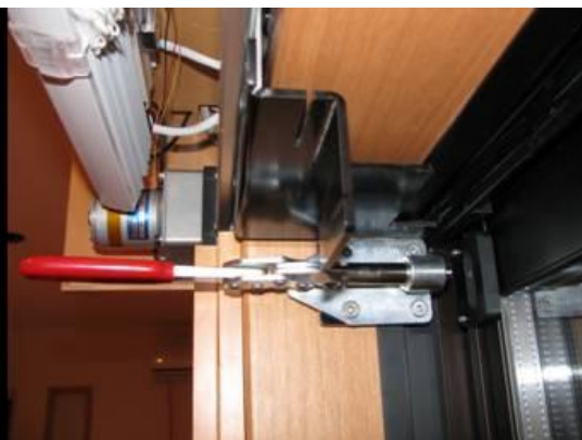
図 b-1-28 窓開閉ユニットと窓サッシとの着脱機構(左図:連結 右図:解放)
