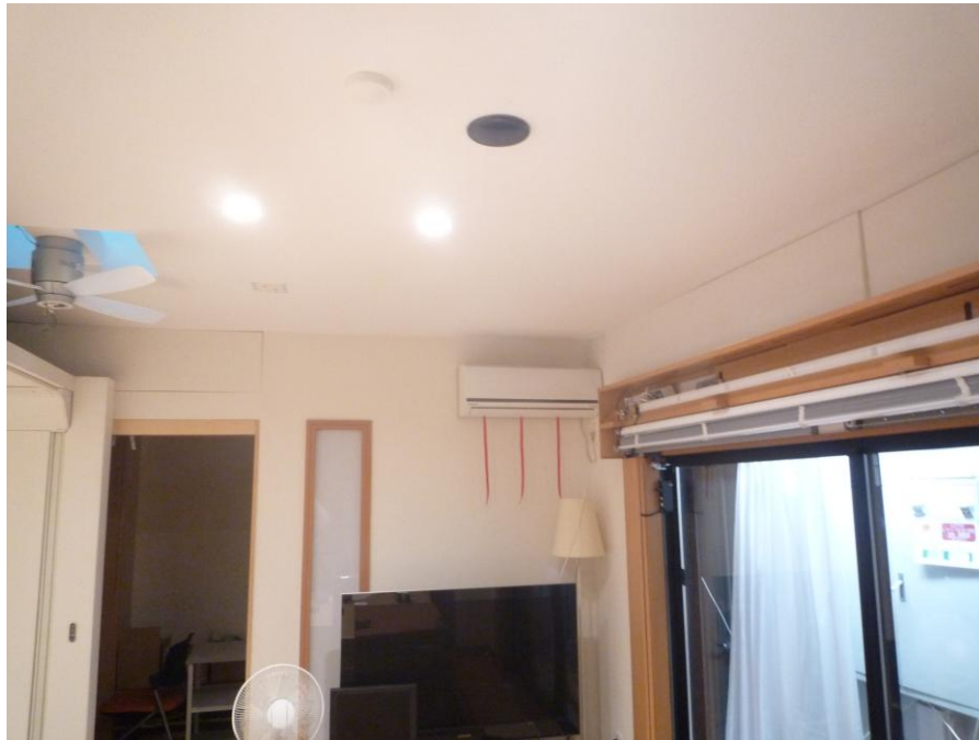
図 b-3-13 産総研実証スペースへの人感センサの設置
