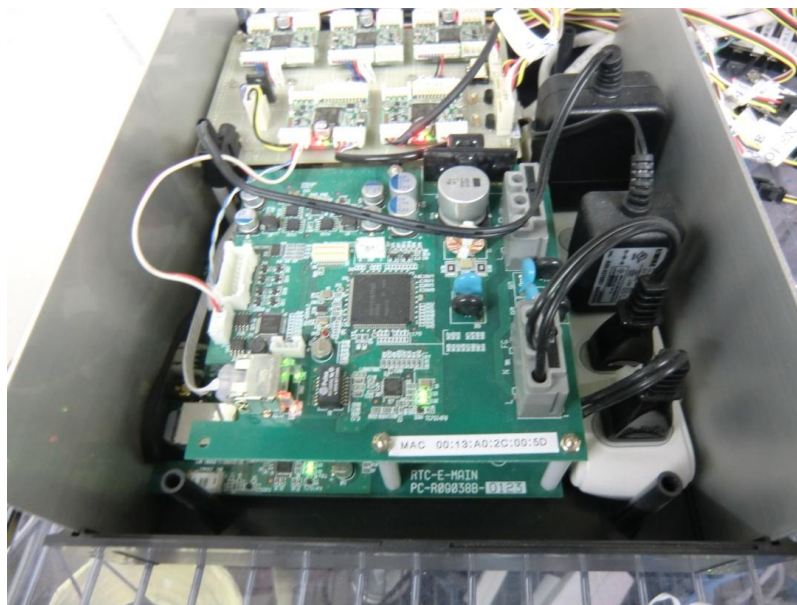
図 c-1-18 建物Bの地下機械室のRT部材写真
