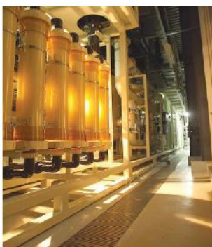
超耐熱性無機ろ材を用いたブリーツ型バグフィルター
