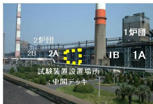
図Ⅲ-2 パイロット試験装置設置場所
